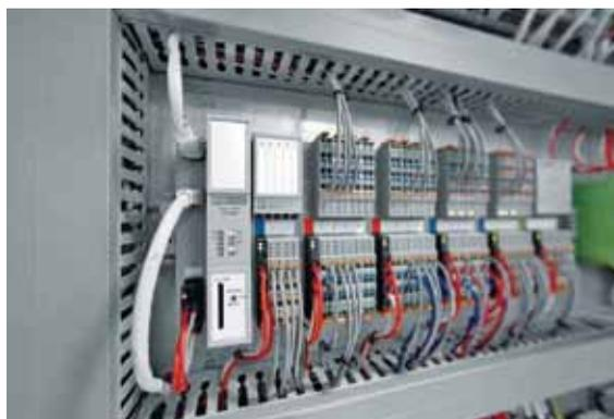
Figura 5. *Axioline* y *Axiicontrol* para una solución continua Profinet o Modbus/TCP
