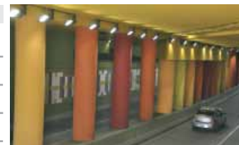
Paso Bajo Nivel Av. San Martín, CABA
