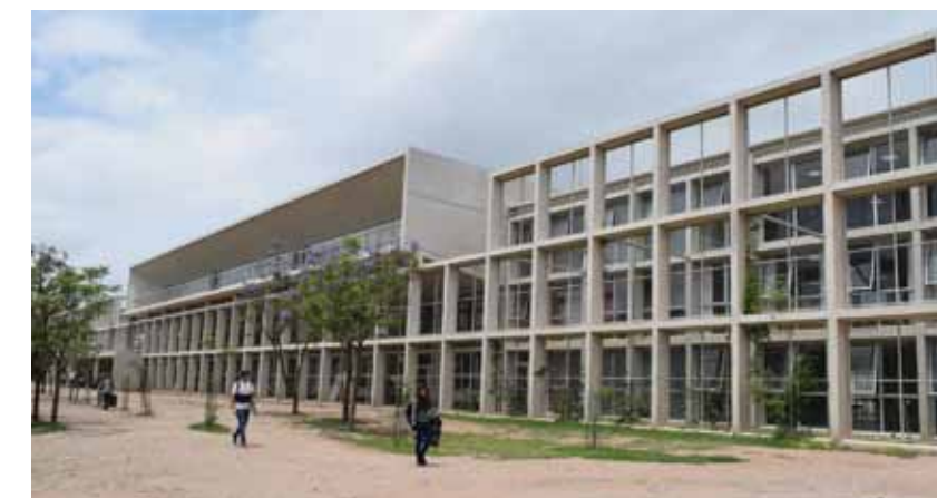
Figura 3. Frente del edificio de la Facultad de Arquitectura, Universidad Nacional de Córdoba
