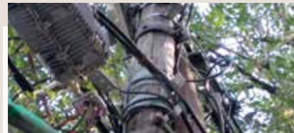
Trabajos en la vía pública del AMBA Luis Miravalles
