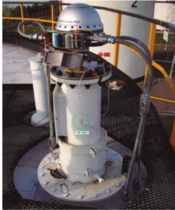
Radar con antena para caño guía
