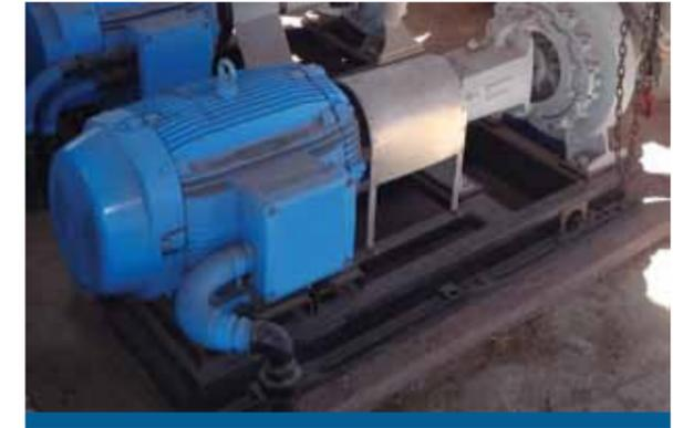
Figura 1. Caso típico de un MET acoplado a una bomba centrífuga
