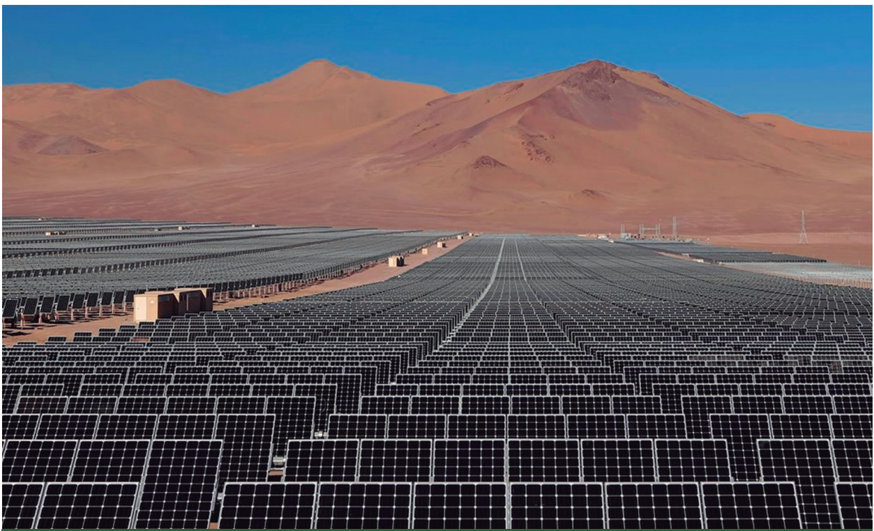
Planta Fotovoltaica Cauchari
