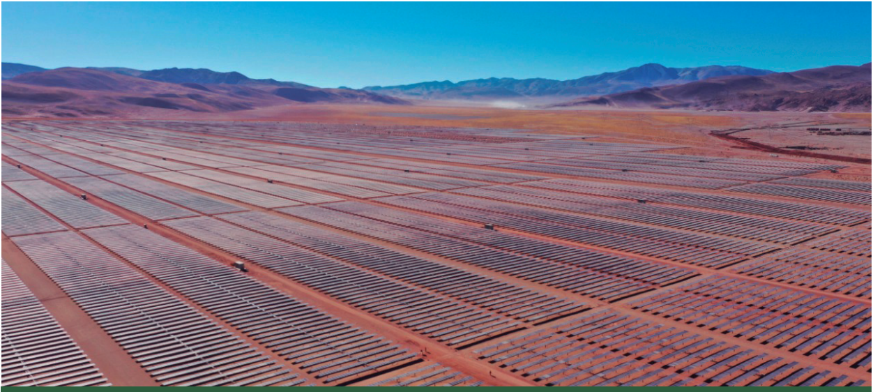
Planta Fotovoltaica Cauchari
