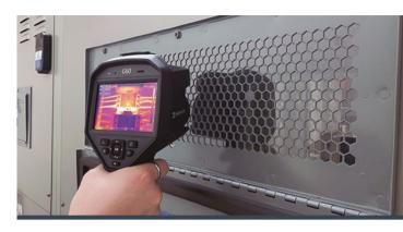
Las ventanas de inspección por infrarrojos son un método de seguridad que las industrias están adoptando. Permiten realizaciones de control del mantenimiento en dispositivos eléctricos y energizados, sin correr riesgos de explosiones de arco eléctrico y otros imprevistos. Son parte de los EMDS, dispositivos de seguridad para el mantenimiento eléctrico que, junto con otros equipos, innovan en el método de inspecciones y mantenimiento preventivo.
