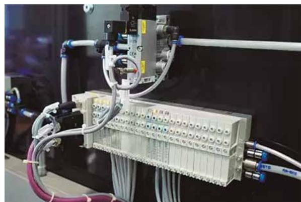
Un terminal de válvulas VTUG suministra la neumática en la estación de ajuste de luz.
