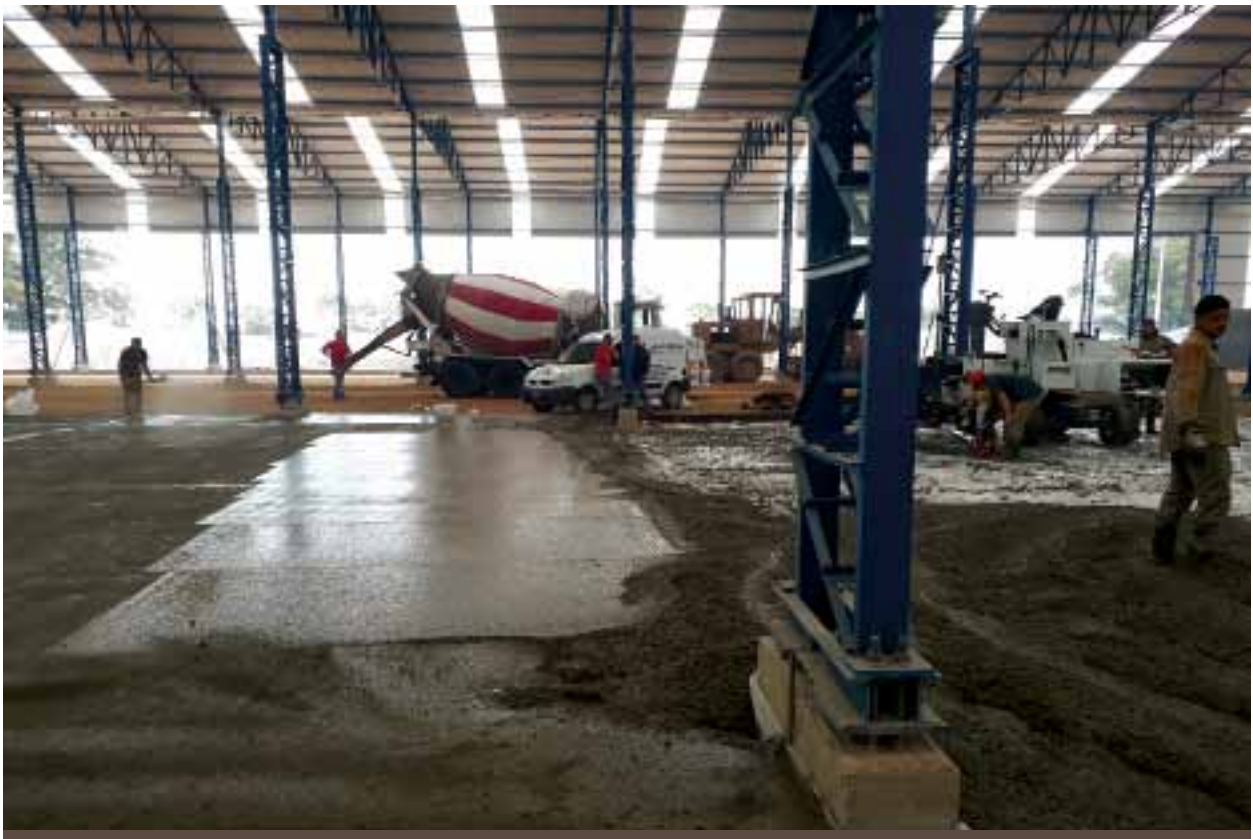
Lago Electromecánica está construyendo su nueva planta en Ezeiza para concentrar su enorme actividad industrial
