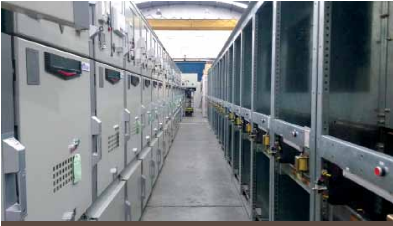
Lago Electromecánica está construyendo su nueva planta en Ezeiza para concentrar su enorme actividad industrial
