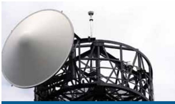
Su principio de funcionamiento está basado en compensar, estabilizar el campo eléctrico existente en su área de protección, de esta manera, anula la formación del trazador ascendente neutralizando el rayo, drenando los campos eléctricos a tierra en forma de inofensivos miliamperes.
