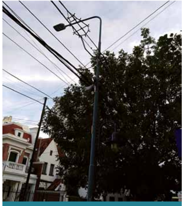
Columna de alumbrado pública próxima invadida
