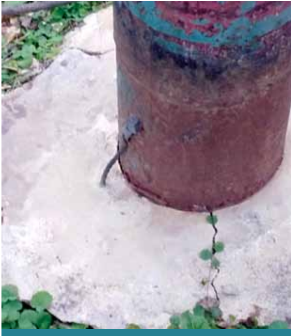
Columna de alumbrado público: puesta a tierra precaria y fundación posiblemente higroscópica, por contener trozos de ladrillo, y corrosiva, por contener cal
