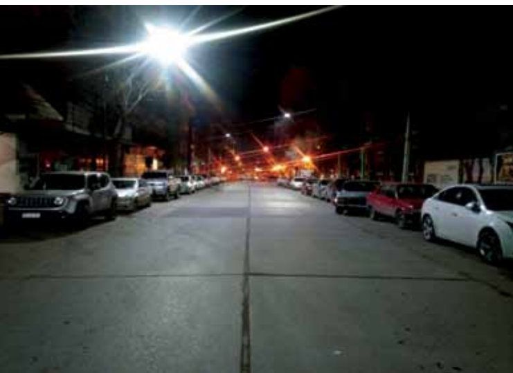
Figura 3. Calle C.H. Rodríguez iluminada con led de 190 watts. Al fondo, la exiluminación con sodio de 250 watts
