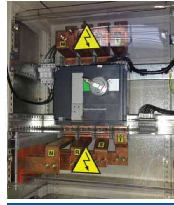
Barras protegida contra contactos
