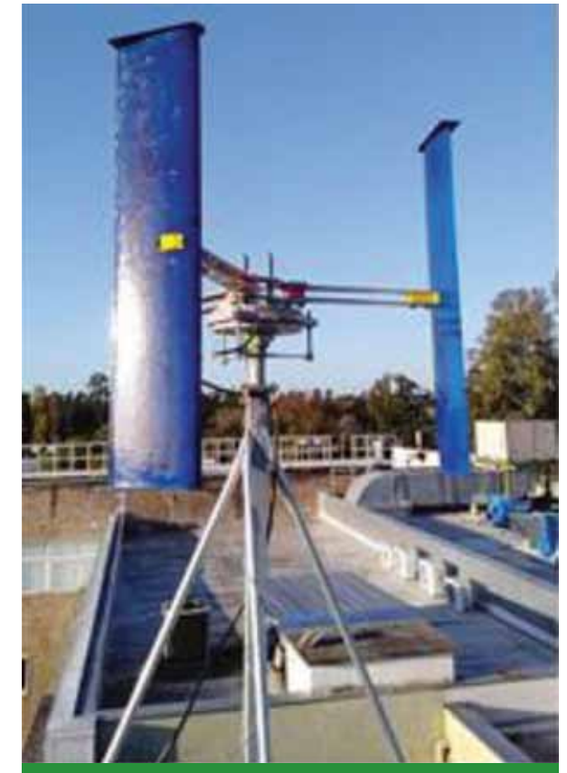
Figura 1. Aerogenerador instalado en la terraza de la Universidad Nacional de General Sarmiento
