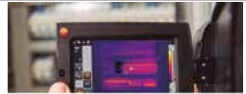
Termografía en alta tensión
