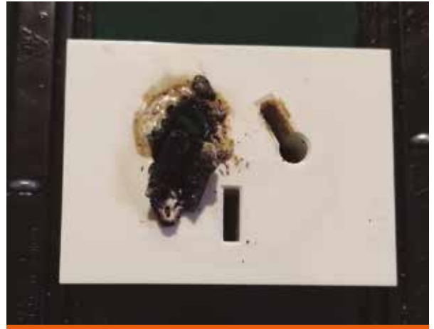
Figura 1. Tomacorrientes "binorma" dañado por falso contacto
