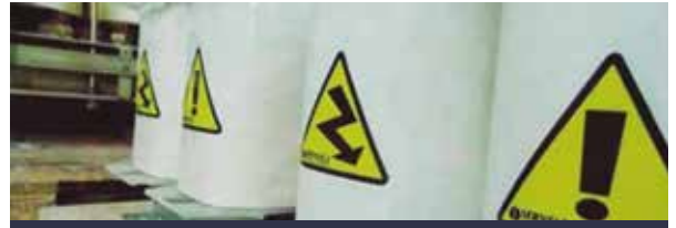
Transformadores de aislación
