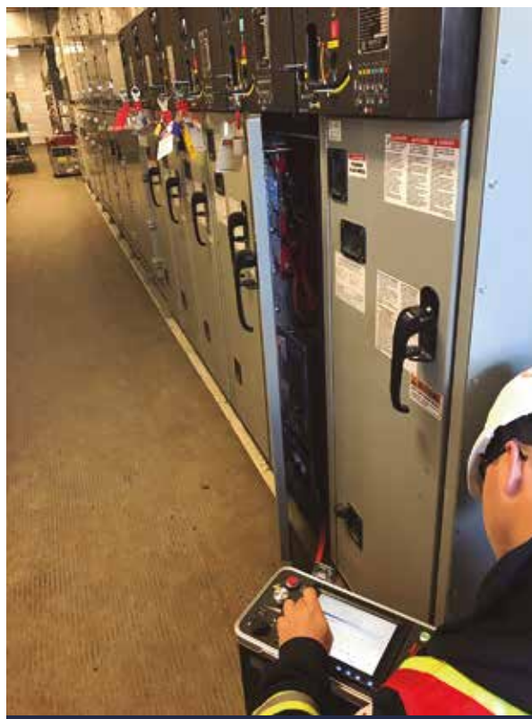
Figura 3. Centro de control de motores Fuente: Imágenes facilitadas por Electrom Instruments
