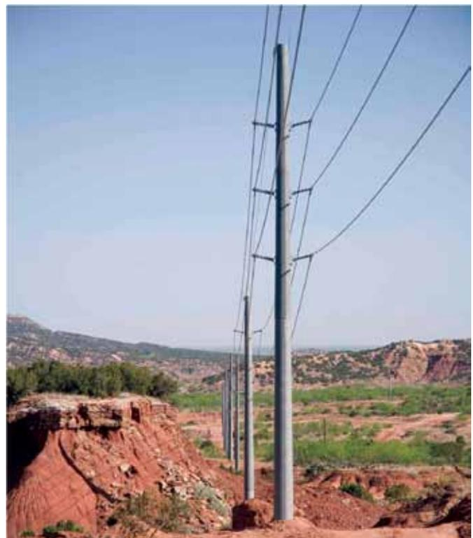
Las propiedades del PRFV son, en gran medida, el elemento principal que convierte a estos postes en una opción a considerar: resistencia a los rayos ultravioletas; aislación eléctrica y no-magnética; alta resistencia mecánica; facilidad de manipulación, instalación y transporte gracias al bajo peso; resistencia al fuego, y resistencia a la humedad y corrosión salina.
