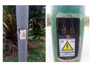
La protección eléctrica y la conexión entre el neutro, la masa eléctrica y la toma de tierra deberían ubicarse en el interior de la luminaria dado que en la explotación siempre se debe acceder a ella. Se reducen así los tiempos de intervención y se mejora su condición de conservación.
