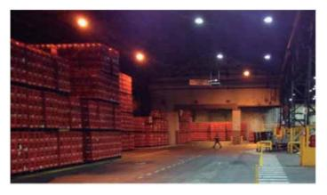
Vista de la instalación piloto con led y sodio de alta presión
