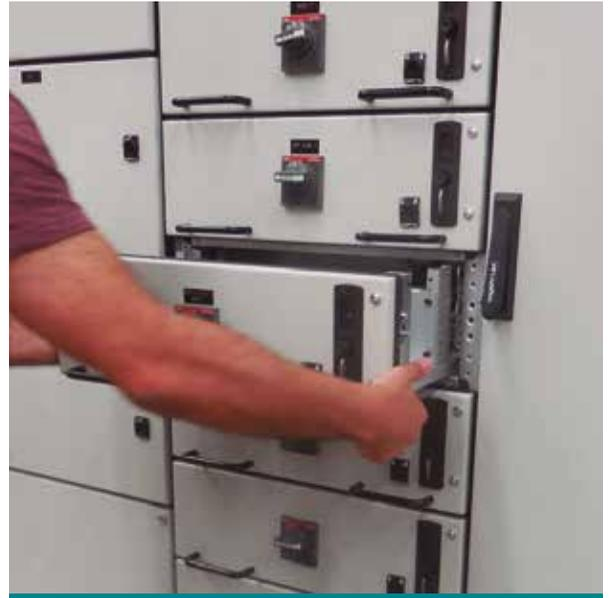
Dentro de la gama de productos de la argentina Nöllmed, está incluida la oferta de tableros a prueba de arco interno para baja tensión de la empresa danesa Logstrup. Se caracterizan por el sistema de control Omega, un sistema modular integral que permite al usuario obtener un amplio rango de tableros y centros de control de motores (CCM).
