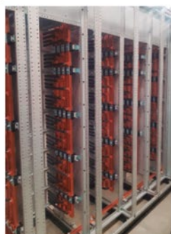
Cabina con tablero Logstrup de 5000 A
