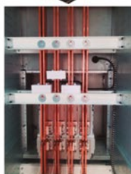
Cabina con tablero Logstrup de 5000 A
