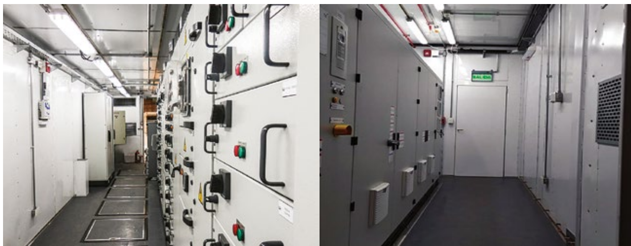
Figura 14. Interior del shelter: tableros e instalación de iluminación
