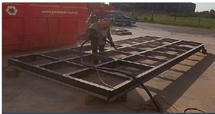
Figura 4. Tratamiento del bastidor de piso
